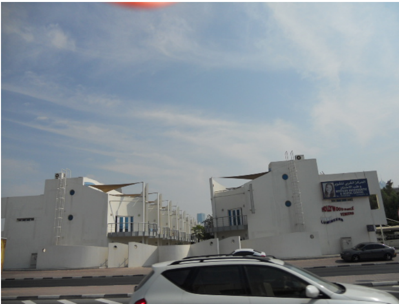
G+1 20 Nos. Villa at Al Bada, Dubai
